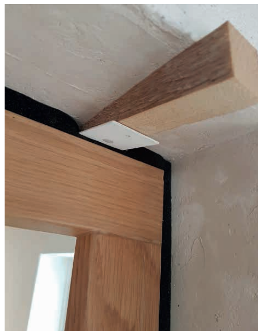
Beim Keilen KU-Klötze unterlegen.
