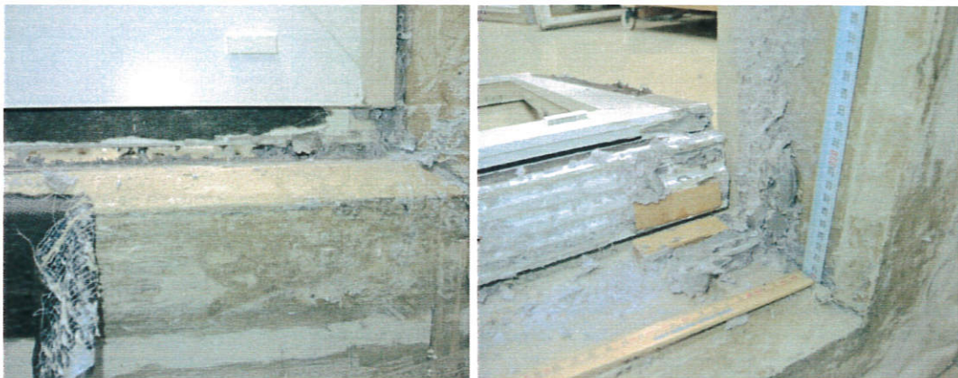
Abb.6: unterer Anschlussbereich mit RALMO-EURO Diffusion Top Fensteranschlussfolie, RALMO-MS-Folienkleber zur zusätzlich Abdichtung im Eckbereich
