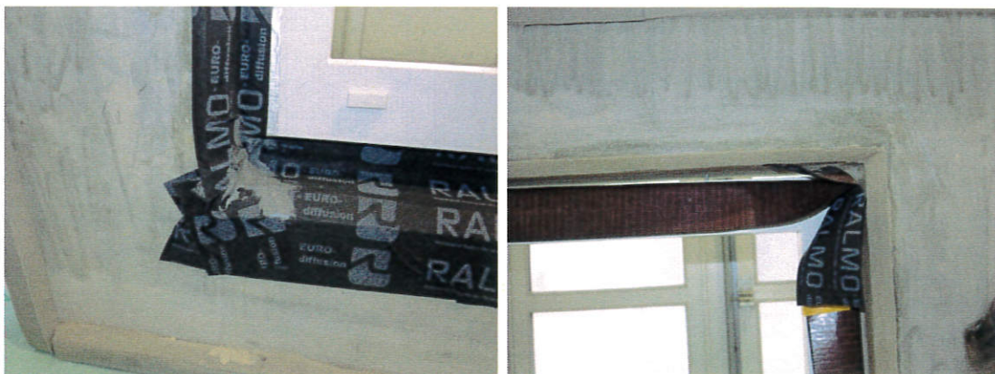
Abb.2: Verklebung RALMO-EURO Diffusion Top Fensteranschlussfolie im äußeren Anschlussbereich
