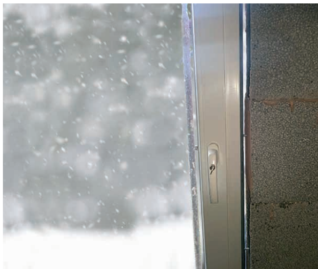
Das Band ist auf Grund der Kälte nicht expandiert
